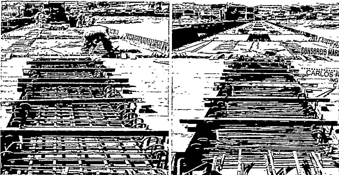
Foto N°02: Acero de refuerzo en juntas longitudinales del puente del nuevo muelle.
